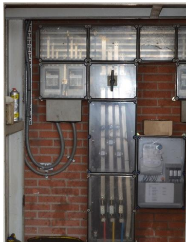
Afbeelding 3: Halyester paneel met actieve, niet-aanrakingsveilige delen achter deksels
